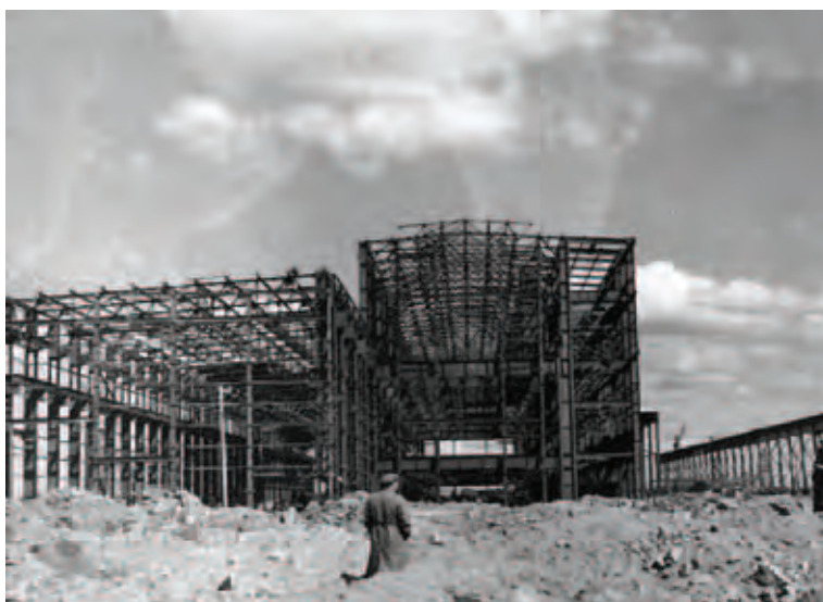
СТРОИТЕЛЬСТВО ПЕРВОЙ ОЧЕРЕДИ ЗАВОДА. Цех №1
